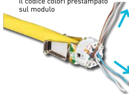
**3** Inserire il modulo cilindrico nel connettore come indicato dalla freccia
