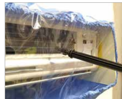
PULIZIA BATTERIA TRAMITE FORO INSERIMENTO MACCHINA PER PULIZIA
