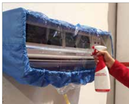
PULIZIA BATTERIA CON TELO DI PROTEZIONE APPLICATO
